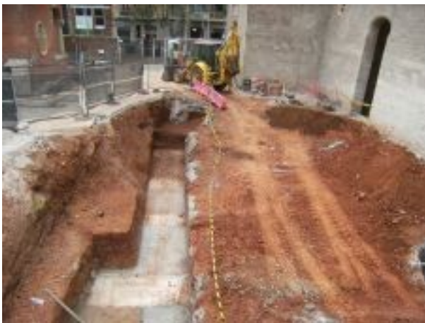
Fotografia 19. Localització de l'estructura UE 143 al sector B
