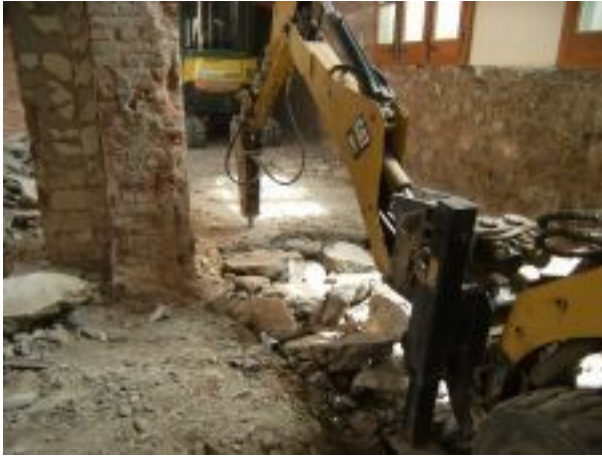
Fotografia 05. Tasques de retirada dels paviments del soterrani del Pavelló de l'Administració
