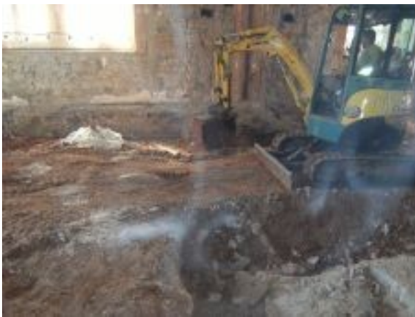
Fotografia 15. Excavació de l'ala oest del sector A2. Es poden observar els fonaments de l'estructura de l'entrepant.
