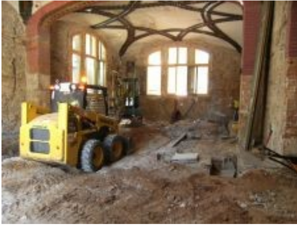
Fotografia 13. Excavació de l'ala oest del sector A3. Es poden observar els fonaments de l'estructura de l'entrepant.
